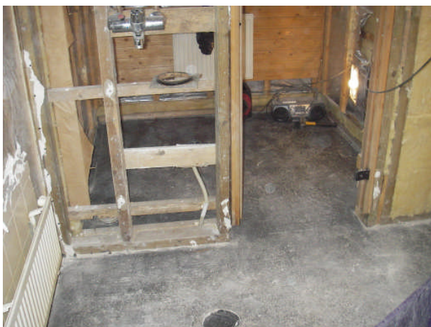
Purkutyöt käynnissä. Seinärungoissa ei vauriota.
