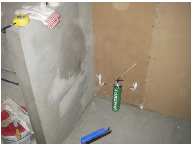
Harkkoseinät on tasoitettu.
