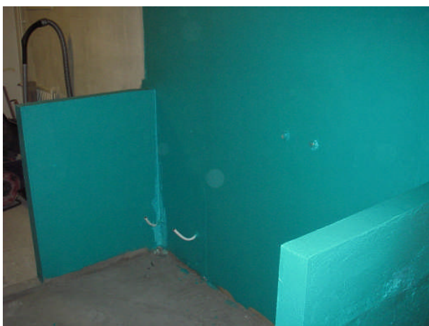
Seinät on vedeneristetty.
