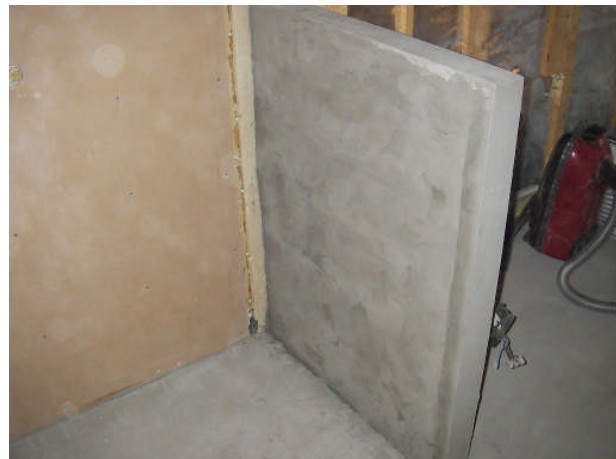
Kulmiin asennettava elastinen saumamassa ennen vedeneristystä.
