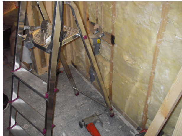
Purkutyöt on tehty riittävässä laajuudessa.
