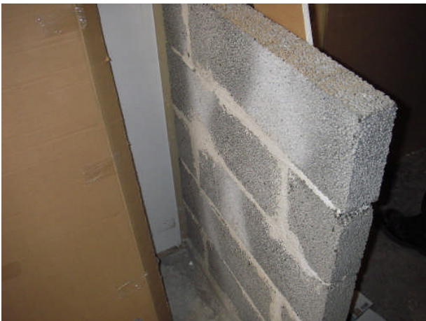
Harkkoseinät on muurattu.
